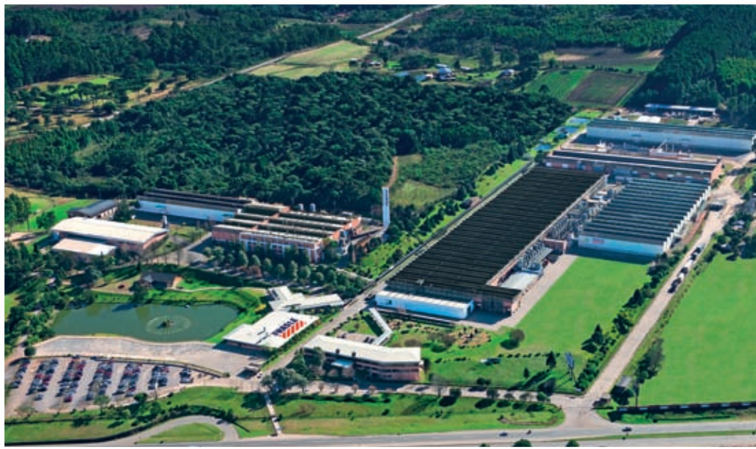
Head Office - Main Manufacturing Facility - Caxias do Sul - Brazil Planta Industrial - Caxias do Sul - Rio Grande do Sul - Brasil
